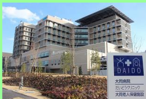
大同病院： 基幹施設
