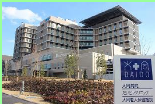
大同病院：基幹施設
